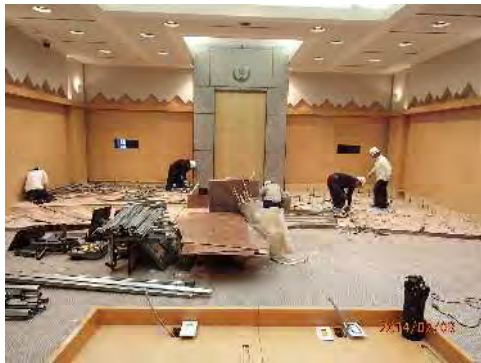
段差のある部分を撤去
