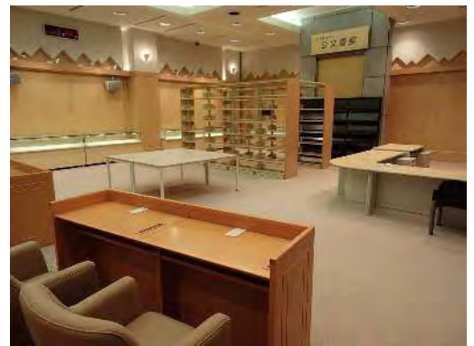
書棚、展示台、カウンター設置完了
