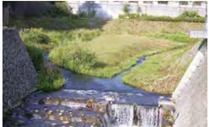
多自然川づくり（道保川 泉橋上流）
