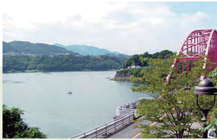
津久井湖（三井大橋）
