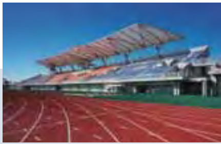
相模原麻溝公園競技場
