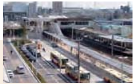
淵野辺駅北口駅前広場
