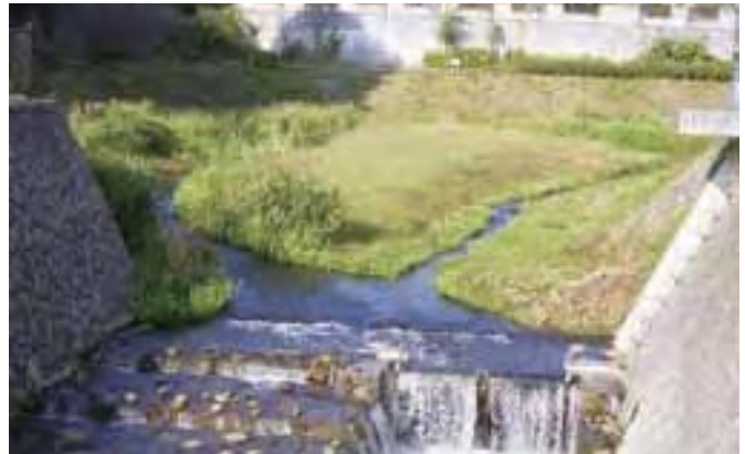
多自然川づくり（道保川 泉橋上流）
