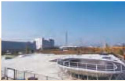
小山公園ニュースポーツ広場
