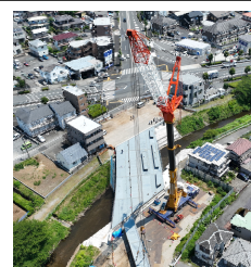
(都) 宮上横山線 橋梁工事
