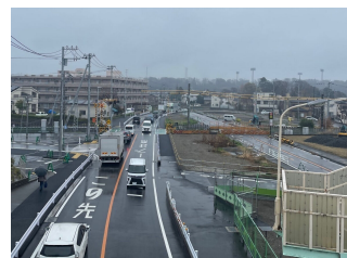
県道52号（相模原町田）立体交差部（道路の切替え及び仮踏切の様子）
