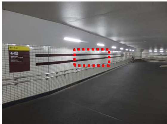
設置前(橋本駅～西武信用金庫側壁面)
