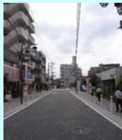
市道南橋本15号線整備事業
