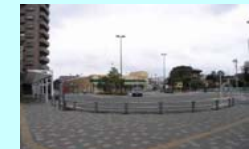
市道南橋本22号線整備事業
