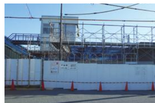
番田駅駅舎（工事中3月2日撮影）
