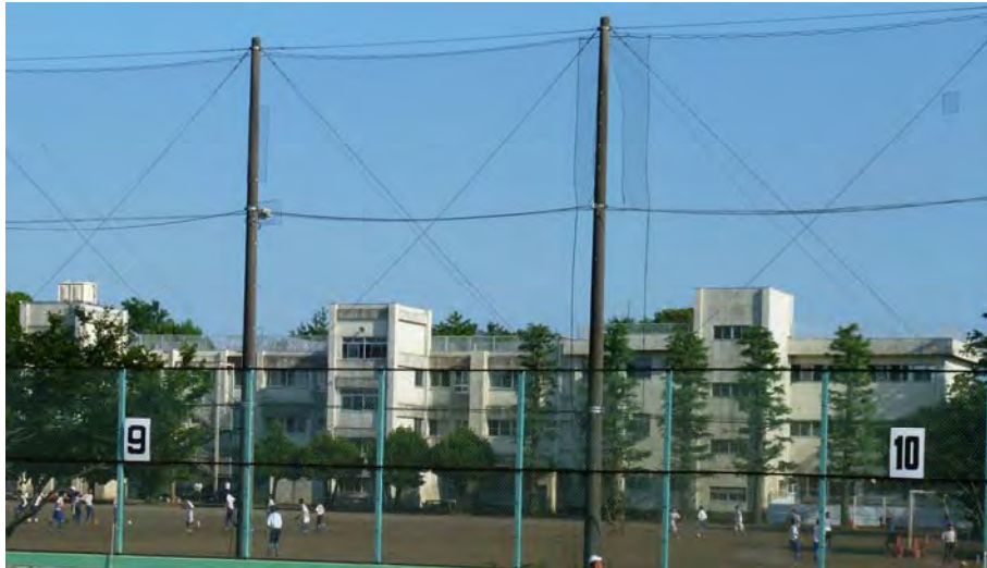
図 上溝中学校校舎外観（グラウンド側から望む）
