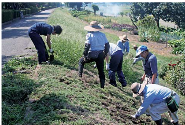
除草作業のようす
