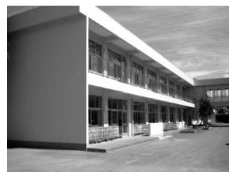
改修した麻溝小学校
