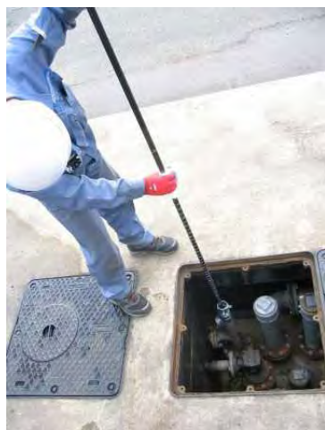
③タンク内より引き上げ
