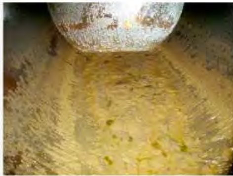
燃料タンク内部清掃作業前
