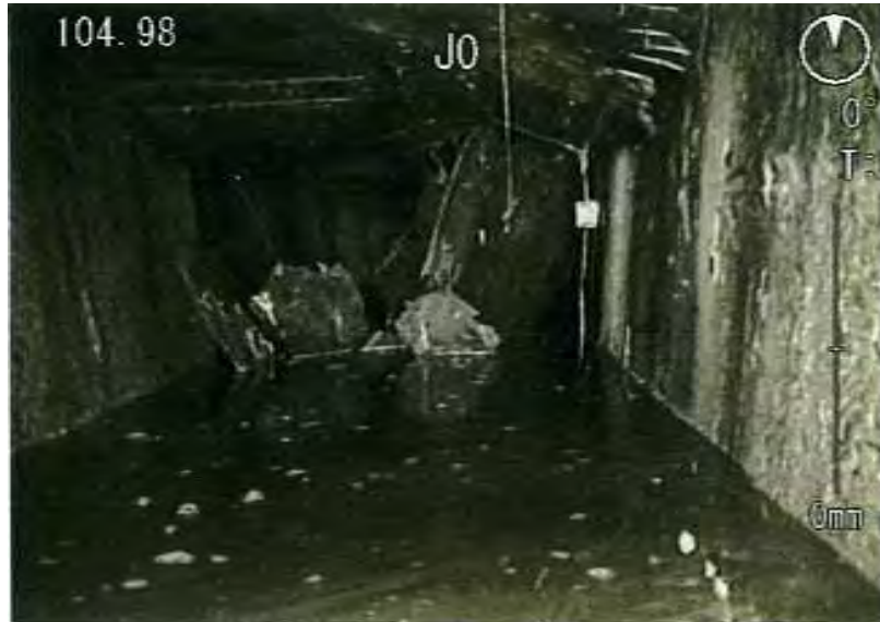
管路の封鎖状況 (松山市提供)
