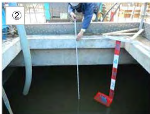
水張り試験（湛水試験）の実施状況
