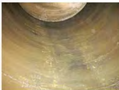
燃料タンク内部清掃作業後
