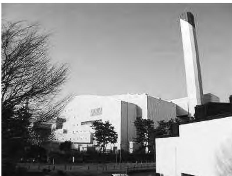
南清掃工場（南区麻溝台）
