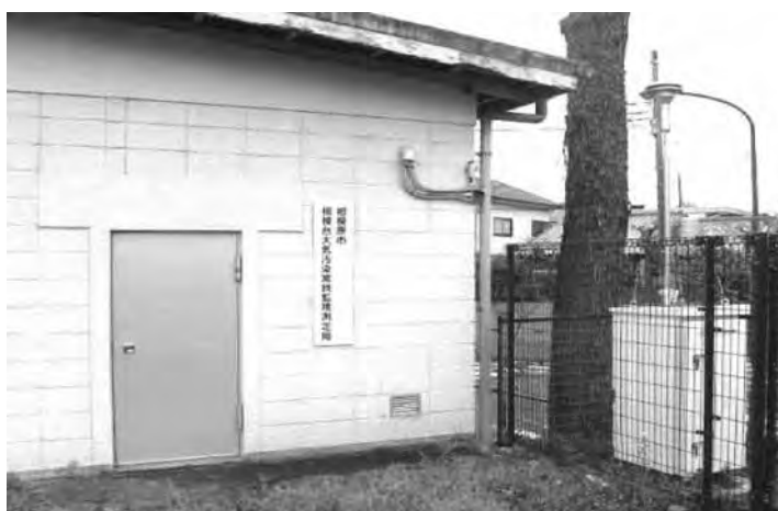
相模台測定局（一般環境大気測定局）外観
