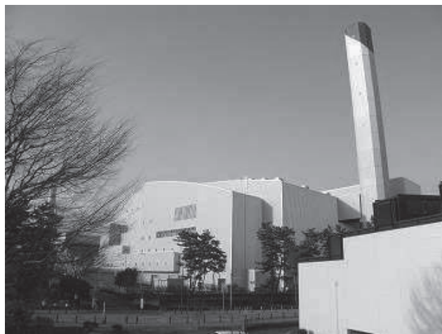
南清掃工場（南区麻溝台）
