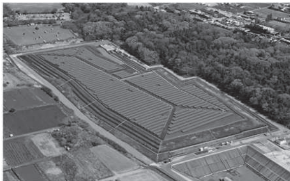
大規模太陽光発電所（ノジマメガソーラーパーク）
