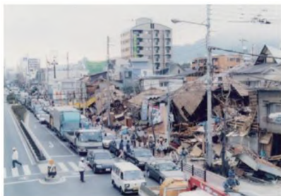
阪神・淡路大震災における建物被害
