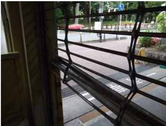
相模大野駅北口自転車駐車場（新館）シャッター破損状況（ガイドレール部）
