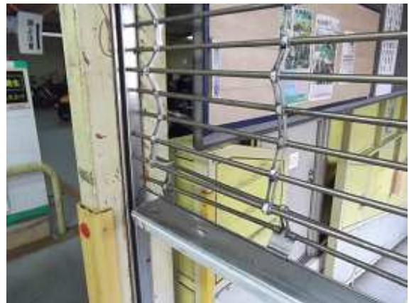
相模大野駅北口自転車駐車場（新館）シャッター破損状況（ガイドレール部）
