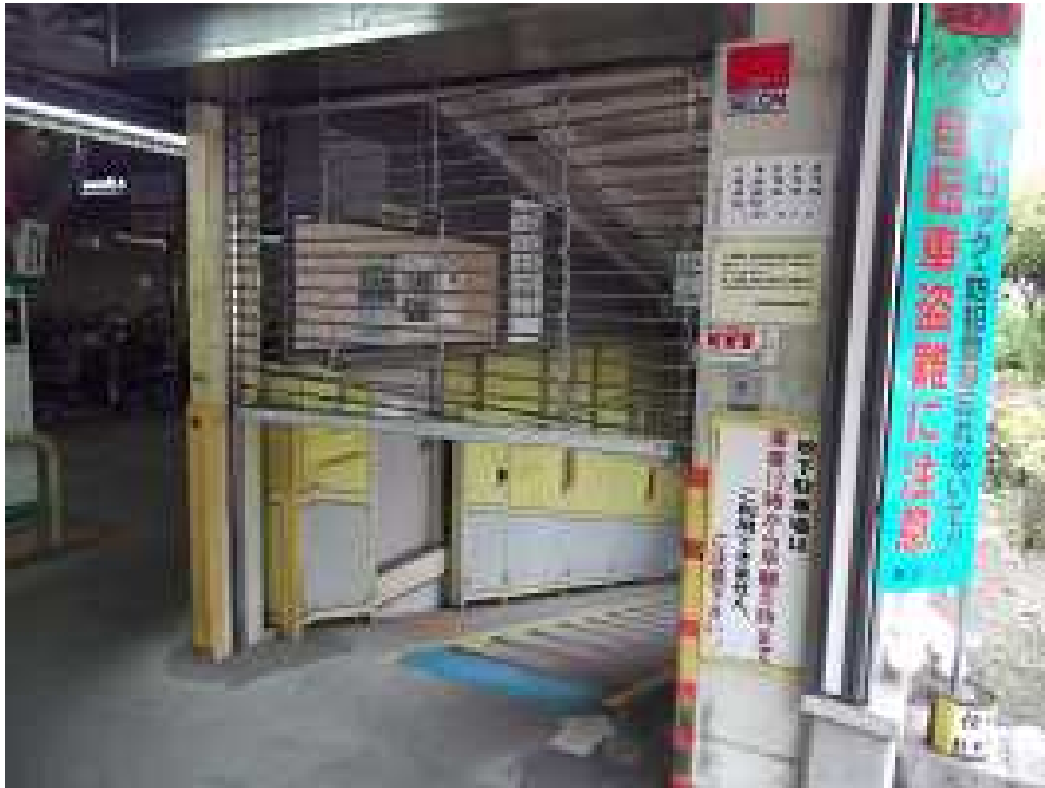
相模大野駅北口自転車駐車場（新館）シャッター破損状況（全景）
