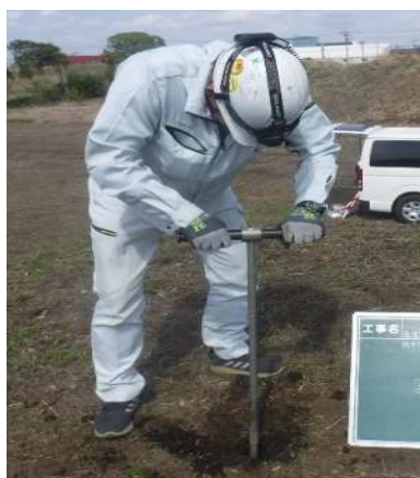
【写真-2】仮置土汚染調査
