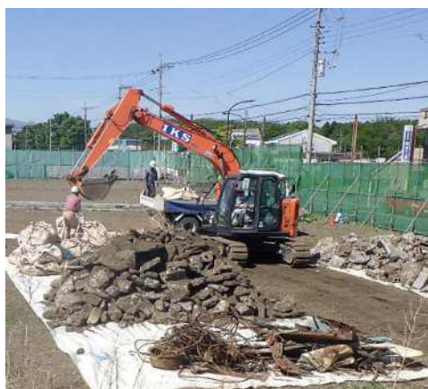
【写真-1】仮置土移設分別工事
