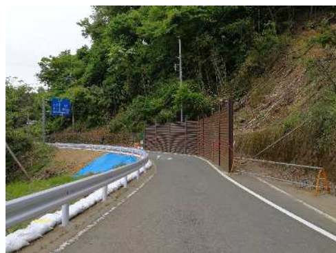
【復旧作業状況】
