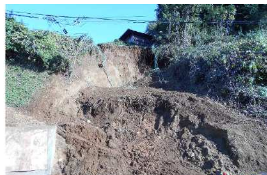
(進入路の法面)
