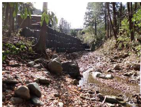
【復旧作業状況】
