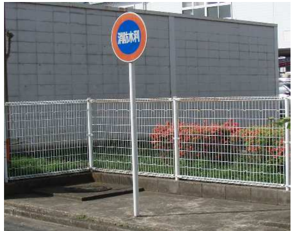
防火水槽の標識
