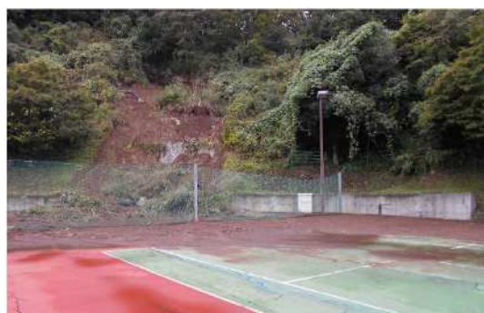
(テニスコート横の法面)
