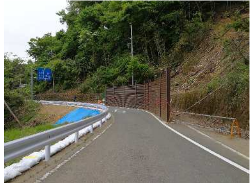
【復旧作業状況】
