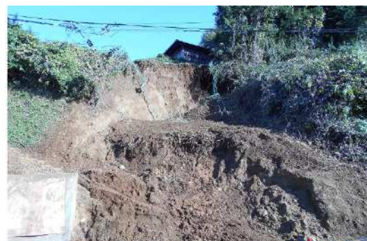
(進入路の法面)
