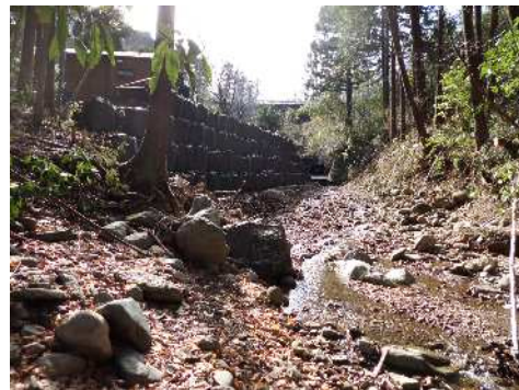
【復旧作業状況】
