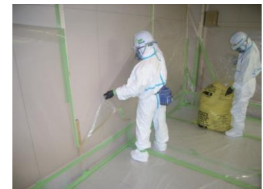
養生シートの撤去
