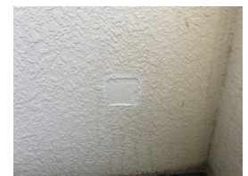
(固化および簡易補修後)
