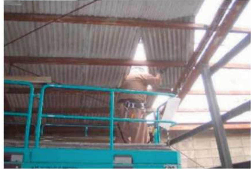
屋根スレート取外し
