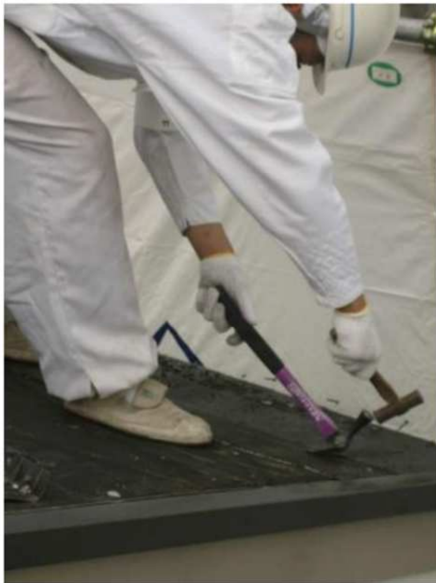
固定部分の取外し※
