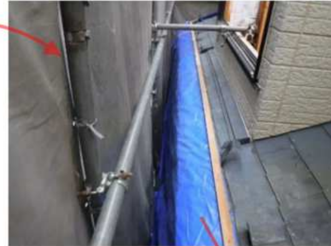
① 屋根にシート掛けし、上から角材で押さえ釘で固定する。
