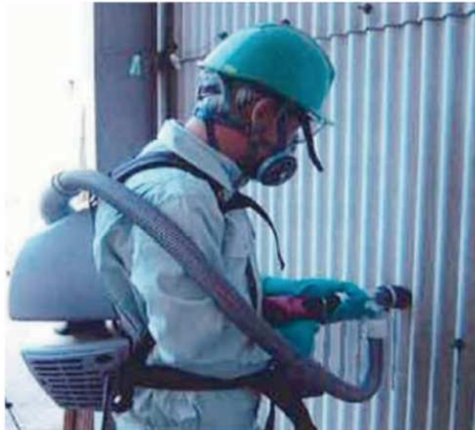
図4.11.7 機械工具による切断例
