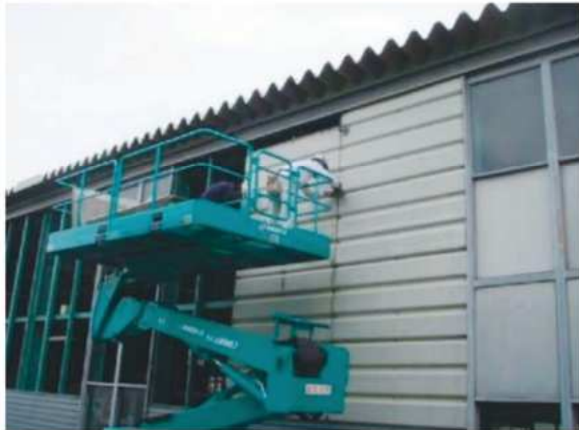
壁金物取外し
