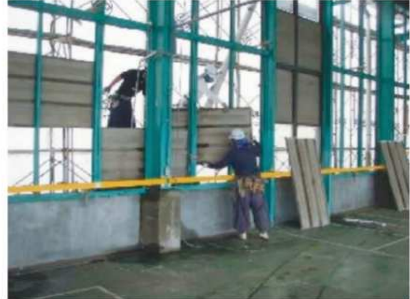
壁石綿含有成形板取外し
