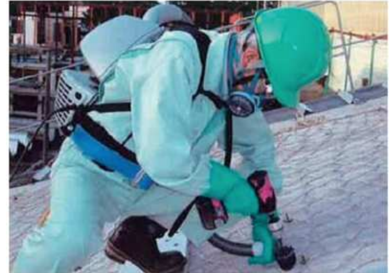
粉じん回収（高性能真空掃除機）
