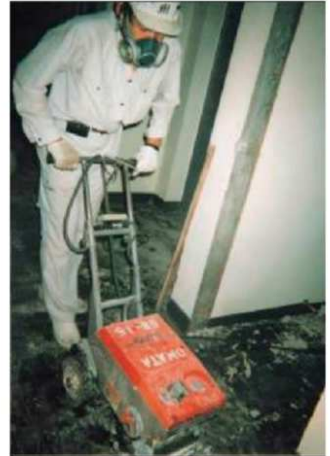
図4.11.12 石綿含有ビニル床タイルの 除去例
