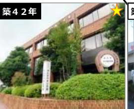
築42年 ★ 津久井中央公民館・津久井老人福祉センター 建築年度：S55 延床面積：2,557㎡
