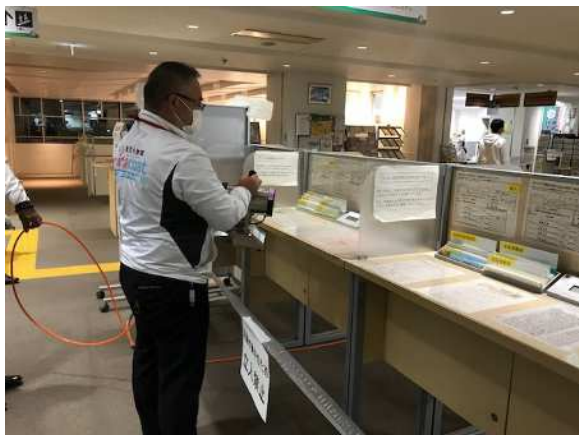
緑区役所 区民課 記載台の施工作业
