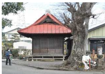
能徳寺の薬師堂(南区磯部)
