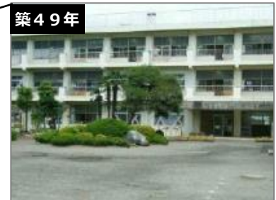
中野小学校 建築年度：S47-H23 延床面積：6,813㎡
