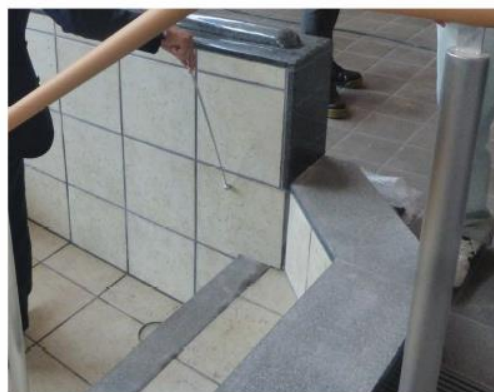
打診棒でタイルをたたき、鬆の有無を確認する 鬆が確認されたら、施工し直す
