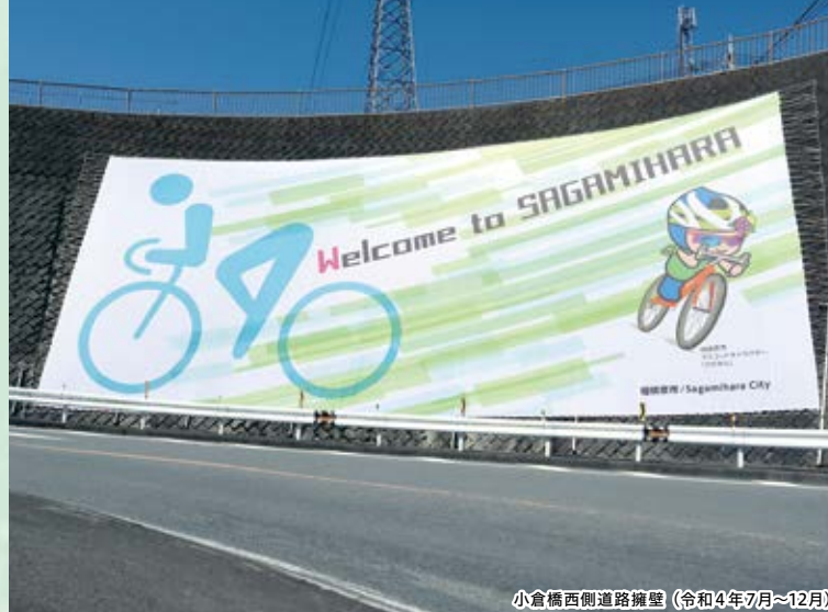
小倉橋西側道路擁壁（令和4年7月～12月）
