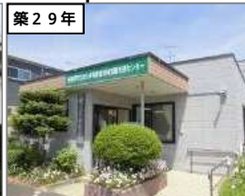
築29年 津久井障害者地域活動 支援センター 建築年度：H5 延床面積：230㎡
