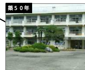
築50年 中野小学校 建築年度：S47-H23 延床面積：6,813㎡
