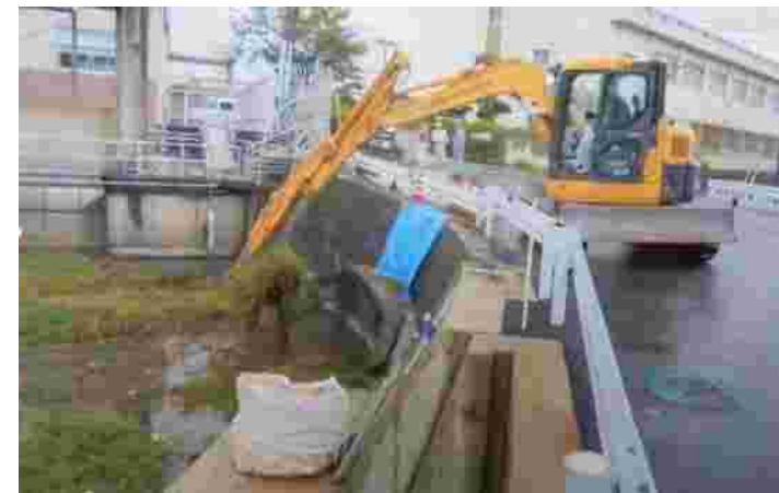
重機による駆除事例
