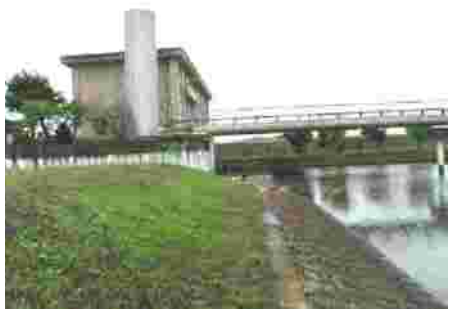
排水機場の法面での生育状況
