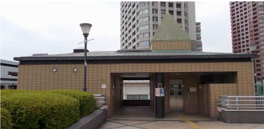
橋本駅北口公衆トイレ（設置前）
