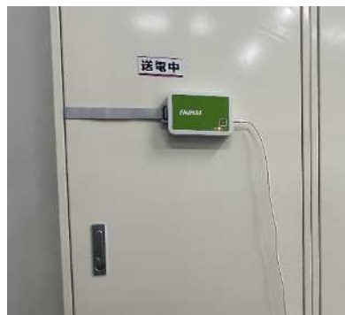
配電盤にポータブル通信電流計を設置（電気工事不要）
