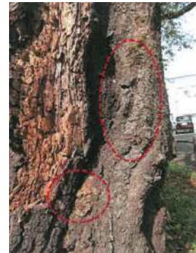
幹の腐朽拡大
