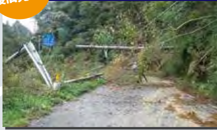
道路沿いの斜面から土砂が流出し、電柱が倒壊
