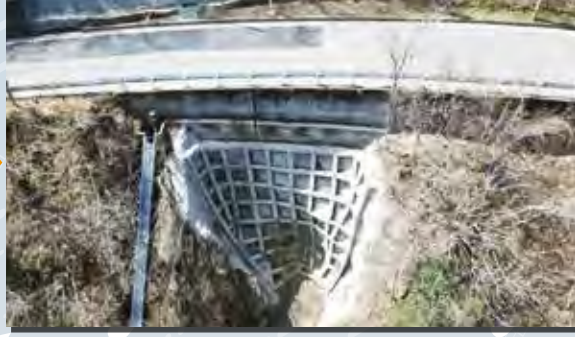
のり面をコンクリートで覆い本復旧完了
