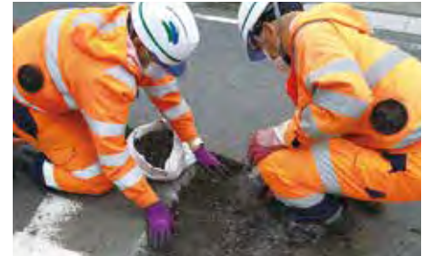
「パッ！撮るん。」から通報が来た道路の穴を補修
