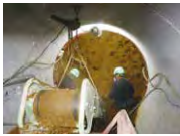
管を掘り進める工事の様子
