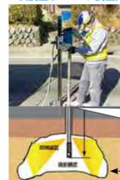
舗装に穴を開けて空洞の調査をしています
